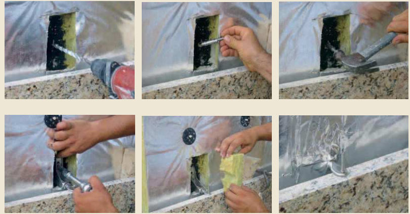
Befestigung von Fassadenplatten mittels Body-Ankern zum Andübeln
